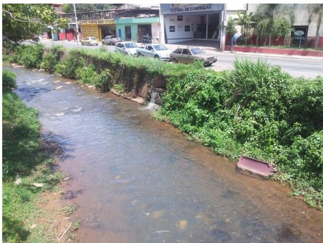
**Figura 6: Lançamento de esgoto no ribeirão Sabará, próxima a sua foz.**
