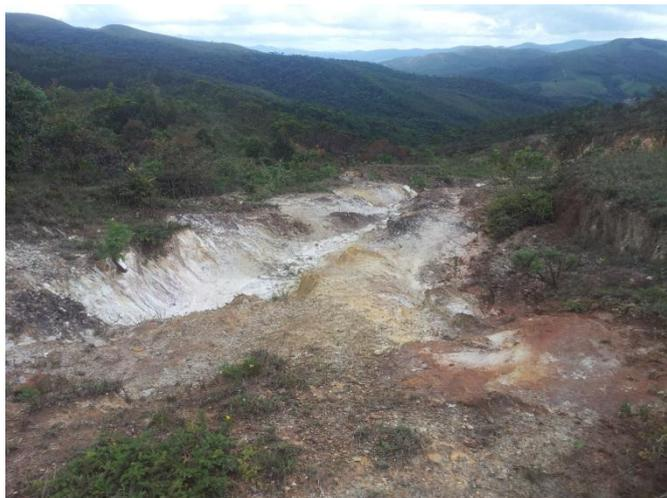
**Figura 13: Processo erosivo às margens de via não pavimentada em Caeté.**
